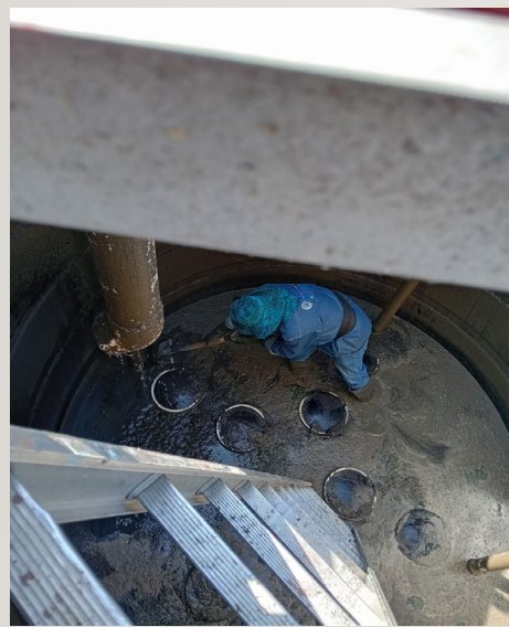
13 de marzo del 2024, arreglo de tubería en reactores en Planta tratadora de tratamiento en Residencial Bosque de los Encinos.
