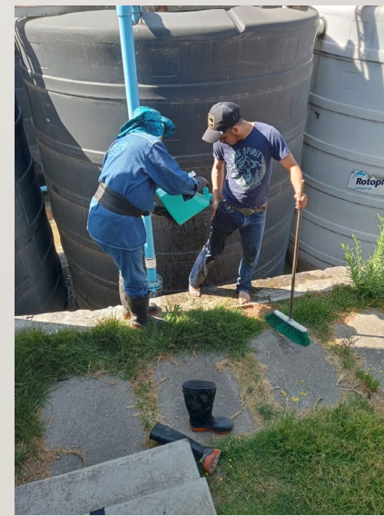
13 de marzo del 2024, arreglo de tubería en reactores en Planta tratadora de tratamiento en Residencial Bosque de los Encinos.
