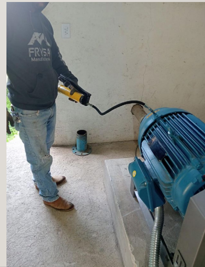
15 de marzo de 2024, suministro e instalación de soplador lobular de 25HP, MOD. 5MS
