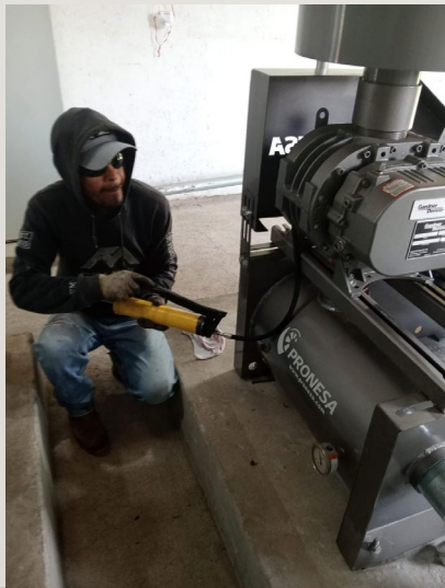
15 de marzo de 2024, suministro e instalación de soplador lobular de 25HP, MOD. 5MS
