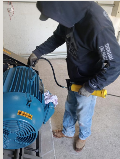
15 de marzo de 2024, suministro e instalación de soplador lobular de 25HP, MOD. 5MS
