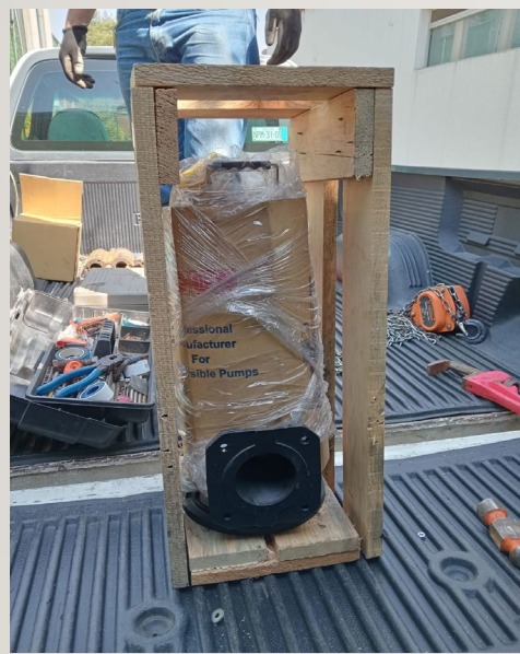
04 de marzo de 2024, instalación de bombas sumergible para lodos.
